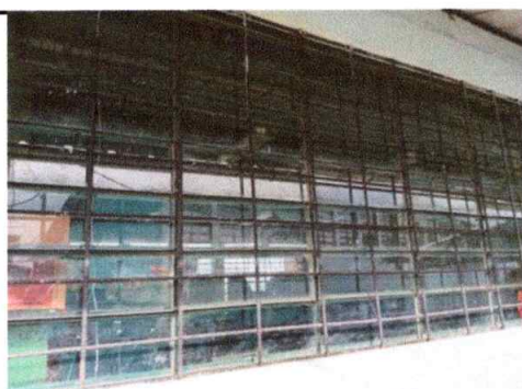
Foto 3: Sustitución de balcones
