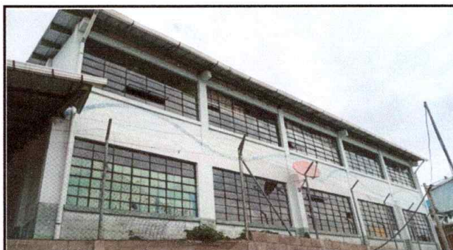
Foto 4: Pintura en muros interiores y exteriores
