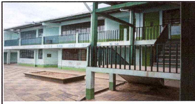
Foto 6: Mantenimiento a barandas de metal
