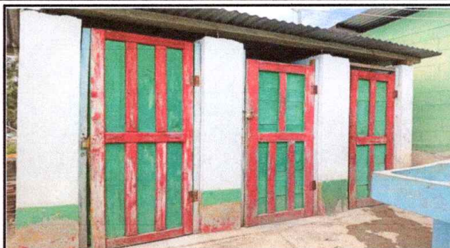
Foto 2: Sustitución de puertas en servicios sanitarios
