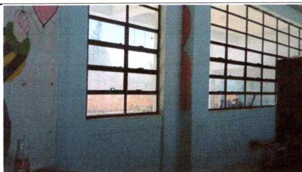
Foto 5: Pintura en muros interiores y exteriores
